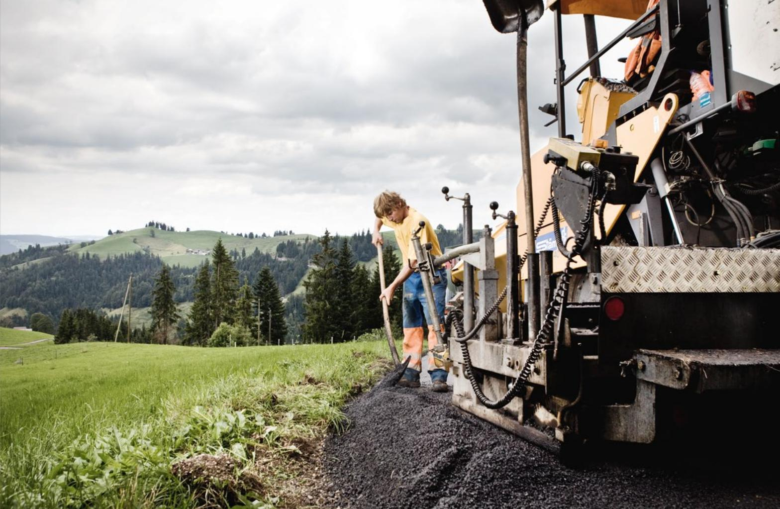
▲ Prima di posare l'asfalto si **livella** il fondo. Altezza e dislivello devono essere precisi.
